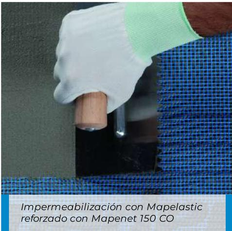
Impermeabilización con Mapelastic reforzado con Mapenet 150 CO
